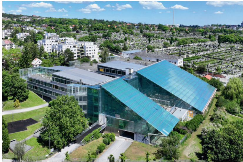
Abb. 9: Wien, ehem. Doppelhauptschule, Kinkplatz 21, Helmut Richter, 1993/94
