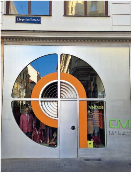
Abb. 2: Wien, Geschäftsportal Boutique Christa Metek, Tegetthoffstraße 3, Hans Hollein, 1966/67
